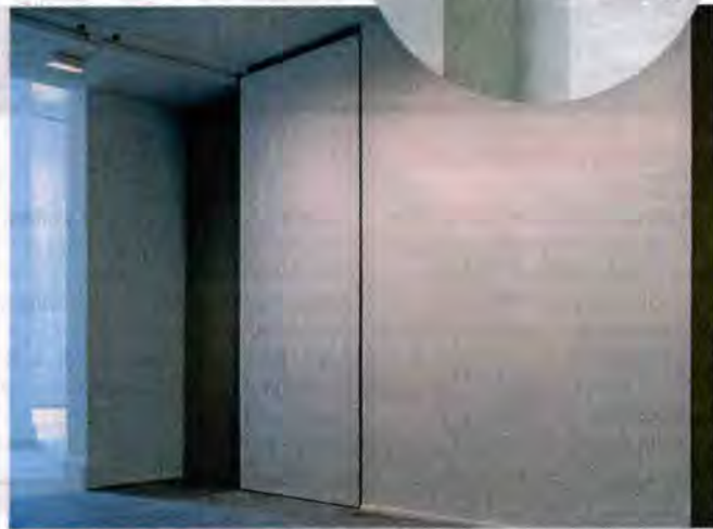
Les amenées d'air neuf disparaissent derrière des grilles verticales métalliques, à la finition thermolaquée.
