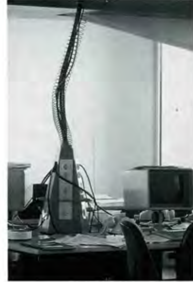
L'énergie et les câbles téléphoniques et informatiques sont distribués par des réseaux situés en plafond et reliés aux groupes de bureaux par des mâts verticaux.
