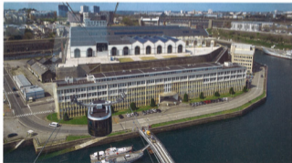
Deservie par le Météphérique, la médiathèque (ou 2 e plan) s'insère dans les nefs d'un ancien atelier de réparations navales de l'arsenal de Brest.
