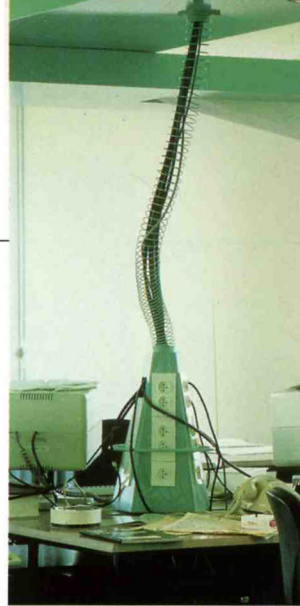
Unkonventionell hängt man am Netz: Die Betonstruktur des Parkhochhauses zwang zu waghalsigen technischen Er- schließungen
