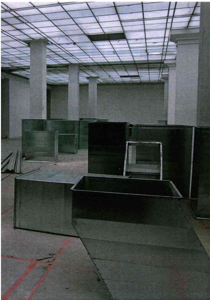
Une gageure: 1 500 m de gaines (soit 30 tonnes d'acier) à guider à travers le bâtiment en préservant visuellement les espaces d'exposition et la fluidité des parcours.
