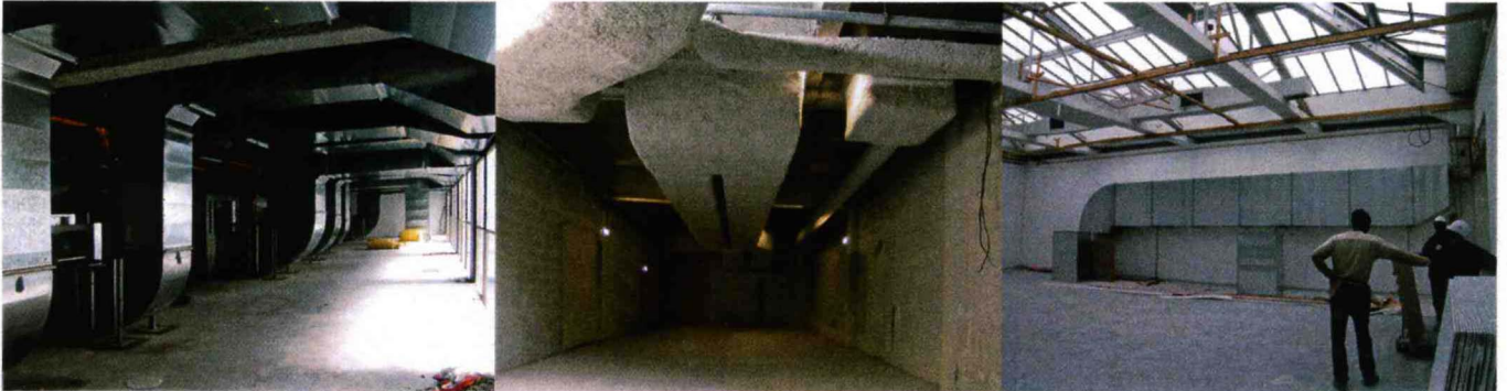
Réseaux de passage de gaines.
