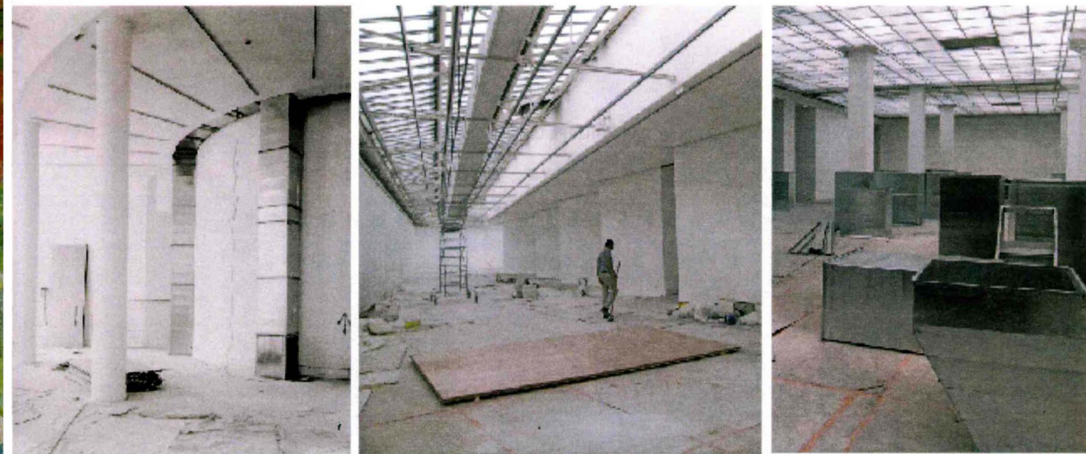
Vue d u chantier à l'intérieur du Musée d'Art Moderne de la ville de Paris © canal architecture
