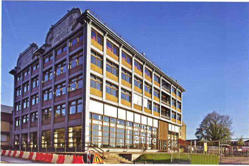
La réhabilitation a respecté les volumes originaux des deux sites accolés
