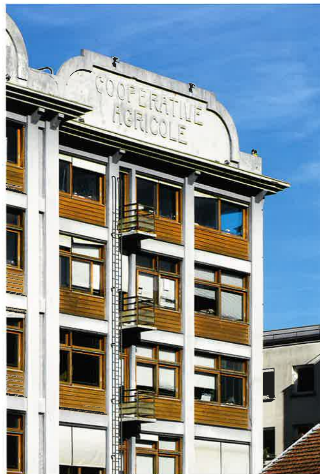
Le fronton en béton conserve le nom de l'ancienne coopérative.
