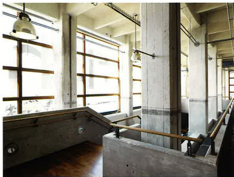
Le bâtiment est composé de quatre étages carrés à structure poteaux-poutres.
