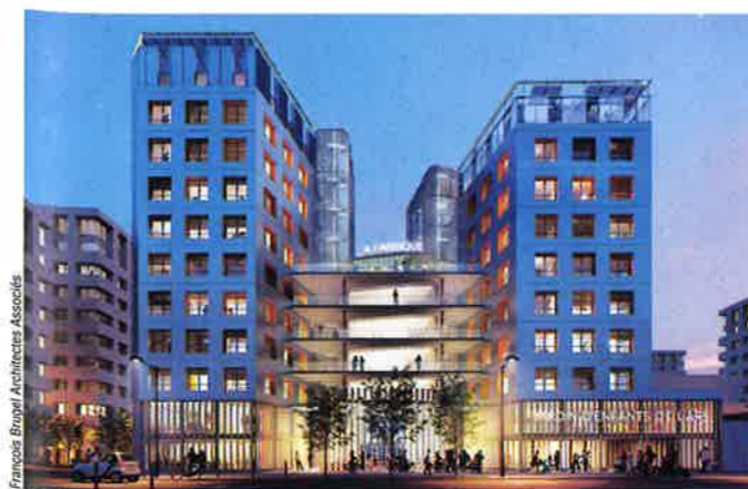
Projet d'immeuble réversible à Bordeaux par Canal (chantier 2022).
