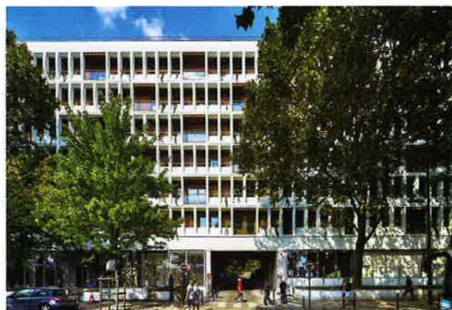
Bureaux reconvertis en logements à Charenton par Moatti-Rivière, 2017.
