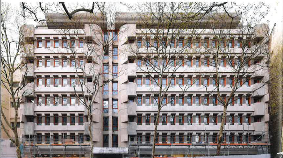
Le bâtiment en cours de rénovation © Pierre L'Excellent
