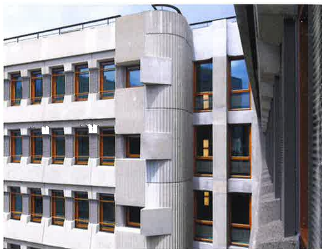
Le projet avant et après travaux, les anciennes menuiseries extérieures, en aluminium, sont réinterprétées en chêne © Canal Architecture
