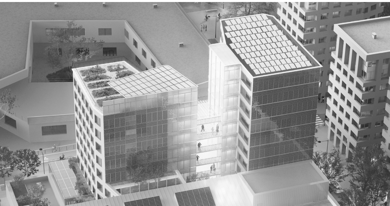
Façade Sud et toitures-terrasses recouvertes de panneaux photovoltaïques assurant la balance à énergie positive
